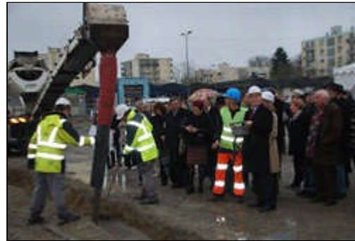
Bernard Poignant aux commandes pour le coulage du béton
